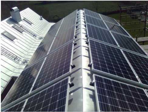
Exempel på anläggning med svag taklutning i ett öst-västläge. Foto: L. Ivarsson
