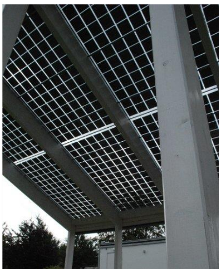
Solceller kan även användas som solavskärmning till exempel som markiser eller uterum. Foto: A. Mattsson
