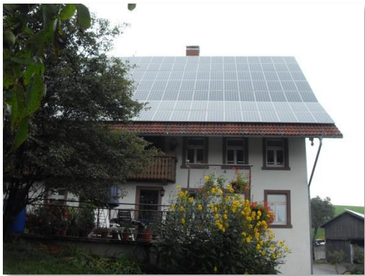
Solcellsinstallation på kulturbyggnad Foto: A. Mattsson
