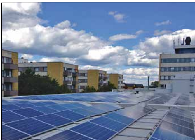
Anläggning placerad på centrumhuset i Skäggetorp.
