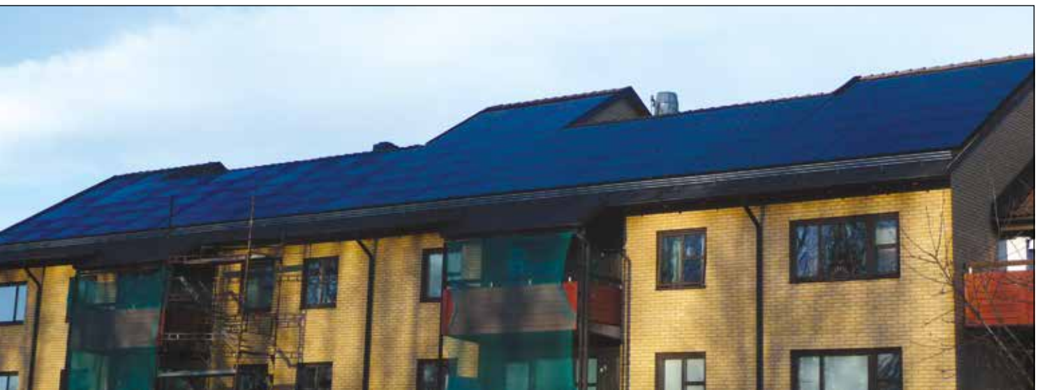
Anläggningen följer takets form.
