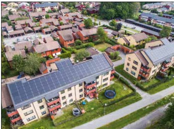
Flerbostadshus i Lambohov. Anläggningen anpassar sig till takets form.
